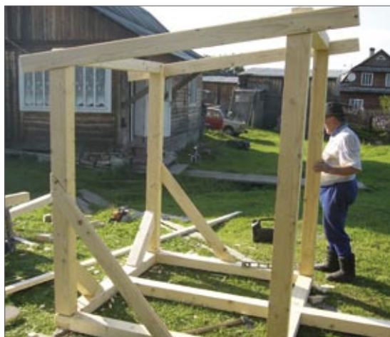
Мал. 6. Будівництво основи для туалетної кімнати з дерева (вгорі), накриття стін дошками товщиною 2 см (внизу)
