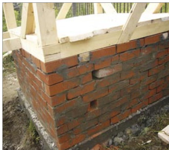
Мал. 4. Будівництво зовнішніх стін компостної камери з цегли (зліва), отвір для труб із сечею (справа)
