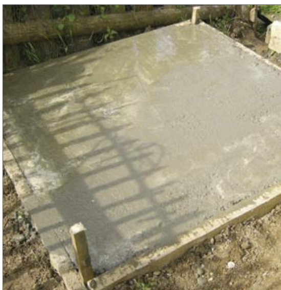
Мал. 3. Бетонна підлога компостних камер: опалубка (вгорі), завершена (внизу)
