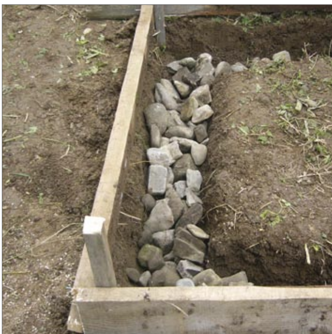
Мал. 2. Котлован під фундамент (вгорі) та заповнення його камінням (внизу)
