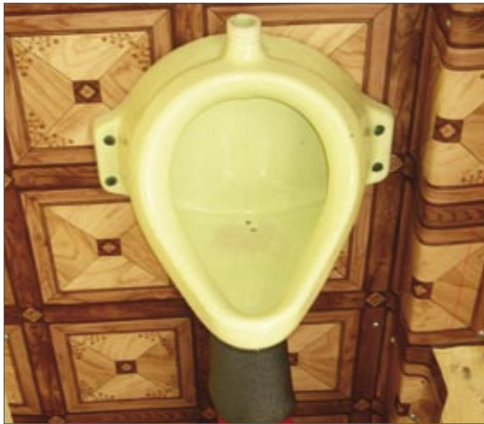
Мал. 9. Пісуар без змиву від „addicom” 1 (зліва) та пристосований керамічний пісуар зі зливом (справа)
