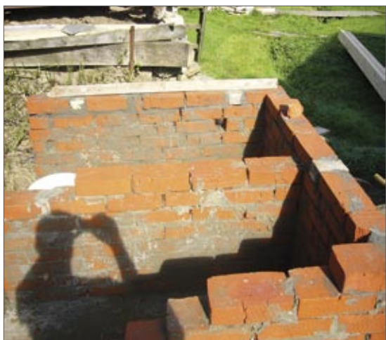
Мал. 4. Будівництво зовнішніх стін компостної камери з цегли (зліва), отвір для труб із сечею (справа)
