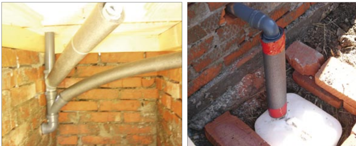
Мал. 10. Шланг для сечі 25 мм з ізоляцією та ПП-трубами 50 мм всередині компостних камер (зліва); невелика двадцятилітрова каністра ззовні туалету (справа)
