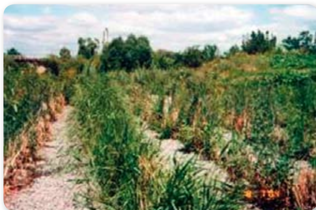
Рис. 4. БІС горизонтального типу, с. Н. Водолага, Харківська обл., 7 років експлуатації.
