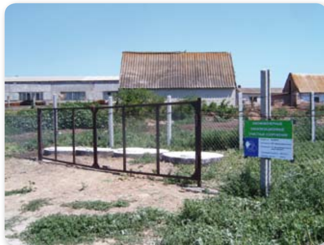
Рис.2. с. Веселе. Територія діючих біоінженерних очисних споруд.
